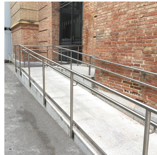
Vista de rampa accesible con doble pasamanos.
