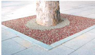
Relleno con material compactado
