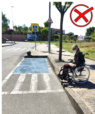
- Espacio de transferencia < 3m - El árbol impide el acceso lateral
