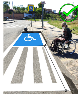
Al no estar el aparcamiento al lado de un paso de peatones, la zona de transferencia debe ser 3 m.
